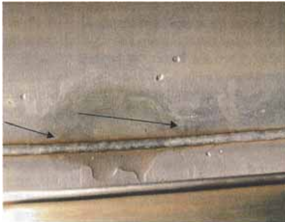
写真1 内部の鏡板の割れの状況
