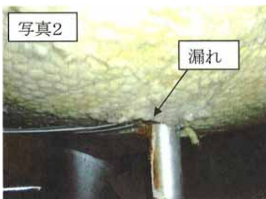
写真2 ドレン抜き管台の外部
