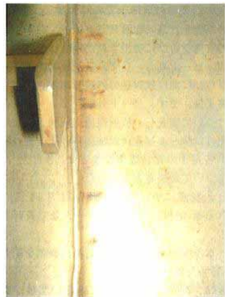
写真 1 カラーチェック前 (内部)
