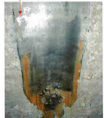
写真2 エロージョン部拡大
