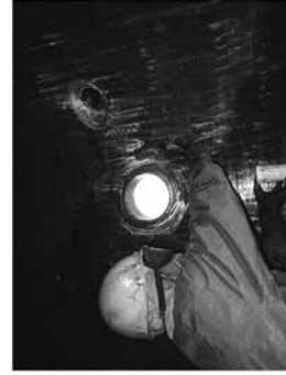
塗料剥離剤の塗布による除去
