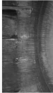
フラッシュタンクの内部状況
