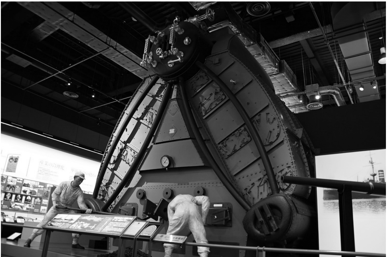
図3 大和ミュージアムで展示中のヤーロー式ボイラー
