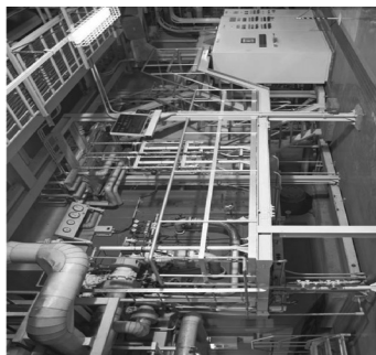
水管ボイラ(1~3B)
